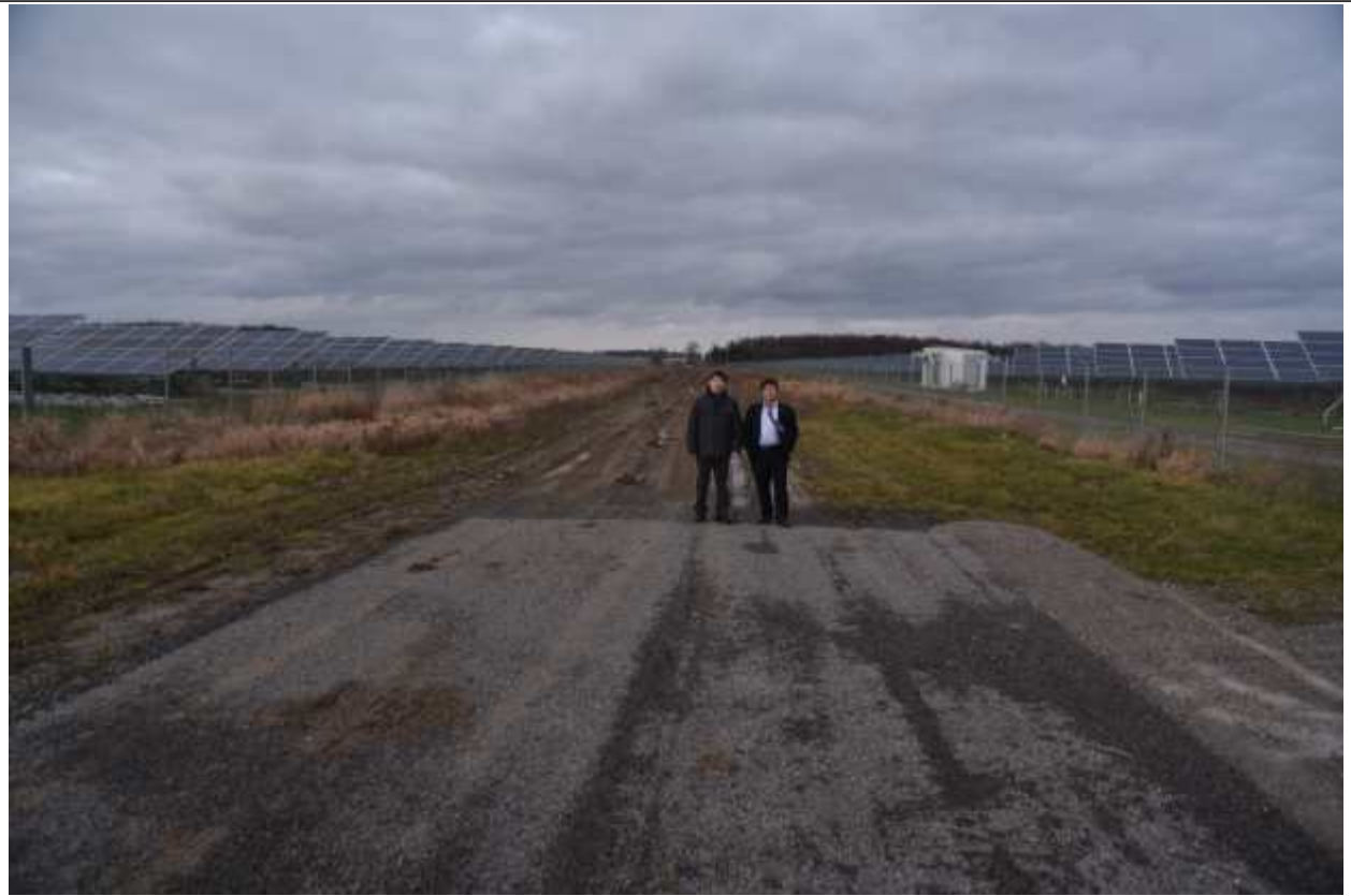
▶ 할디만디 태양광 발전소 현장사진 4
