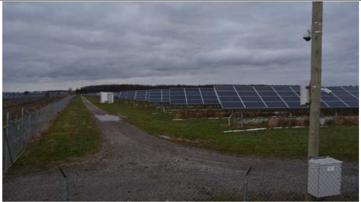
▶ 할디만디 태양광 발전소 현장사진 2
