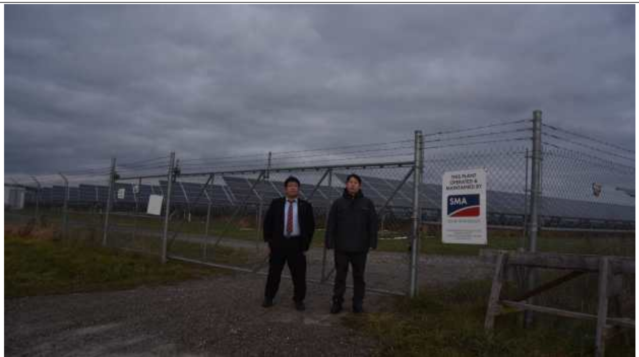
▶ 할디만디 태양광 발전소 현장사진 3
