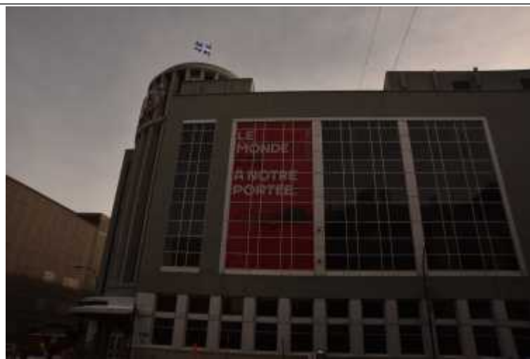
▷ ETS공대 메인 파빌리온 전경
